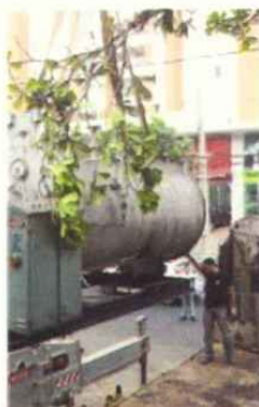
Caldeira antiga que foi retirada ontem do HGG
